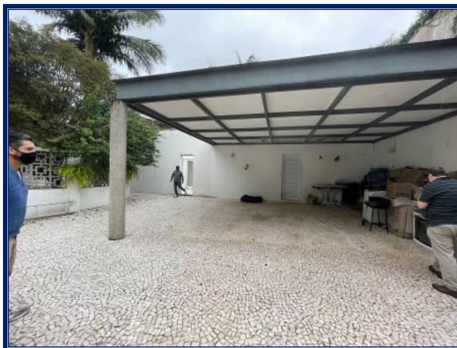
Edícula: Vista externa da cobertura da garagem.
