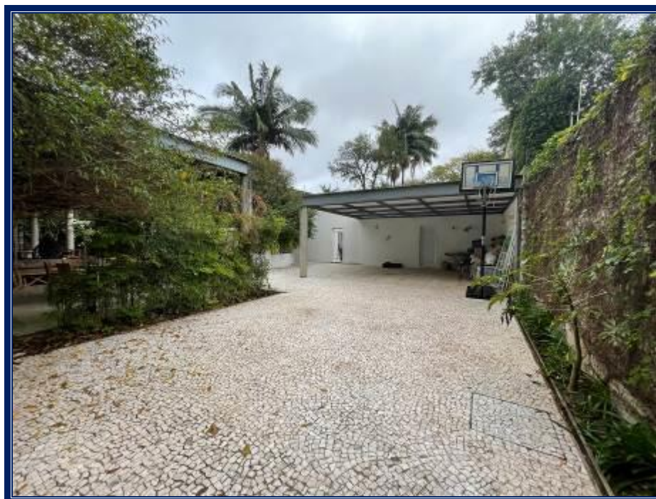
Edícula: Vista externa da cobertura da garagem.
