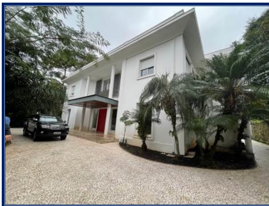
Vista externa do corpo principal.
